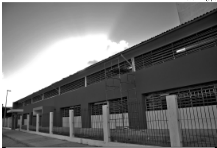
As obras nas unidades escolares serão concluídas até o final deste mês
